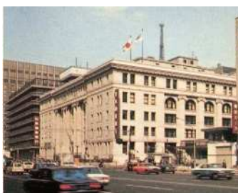
旧 第一勧業銀行本店ビル
