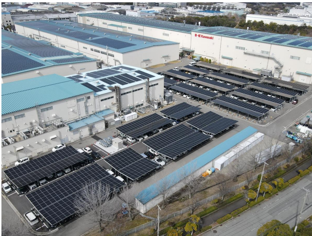
写真手前から広がる駐車場全域のカーポートが今回導入された設備（工場屋根上の太陽光パネルは既存設備）。
