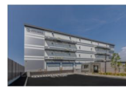
八尾物流施設 (2025年8月竣工)
