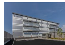
八尾物流施設 (2025年8月竣工)
