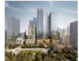
南地区 (サウスタワー)
