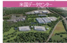
米国データセンター
