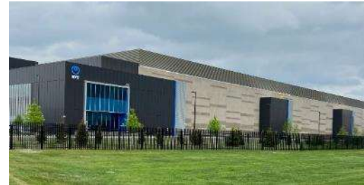
米国シカゴのデータセンター
