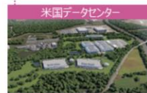
米国データセンター 2025年以降順次開業予定
