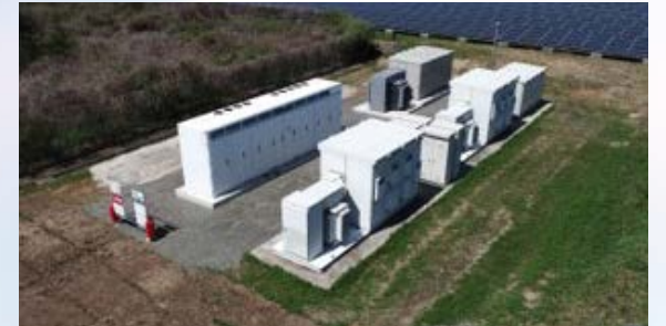
熊本・荒尾メガソーラー発電所に設置した併設型蓄電池
